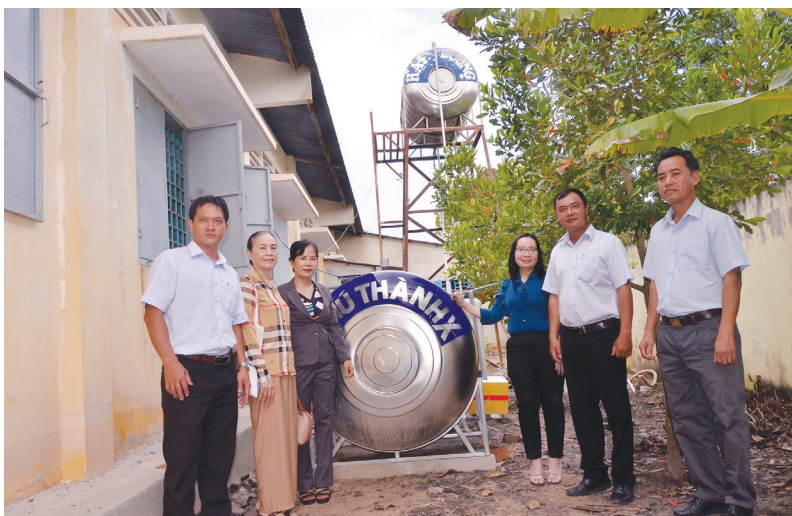
Nghiệm thu hệ thống lọc nước tại Trường Mẫu giáo Suối Đá
